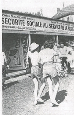
Jour de 1967. Les caisses de la sécu sont gérées par des administrateurs élus. © DR
